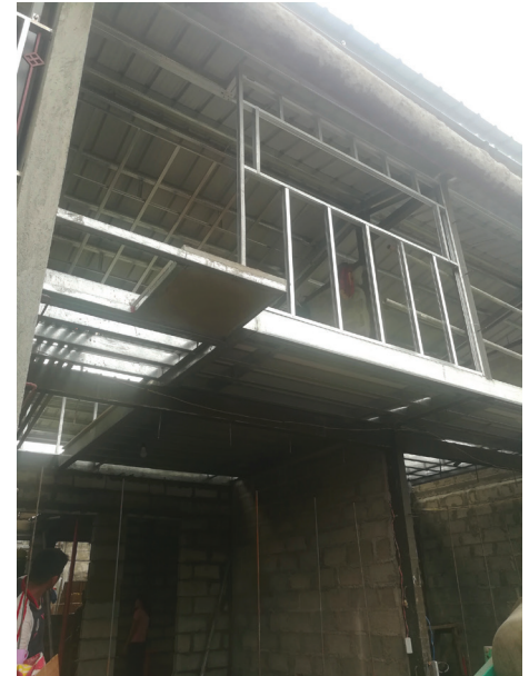
Isang halimbawa ng construction project sa Kausawagan, Cagayan de Oro City na gumagamit ng light metal frame. (Larawan mula sa Priometal Mindanao Corporation)
